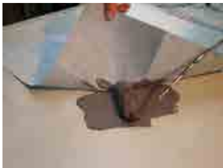
7. Обмазаната хидроизолация се разнася по цялата площ под мембраната
