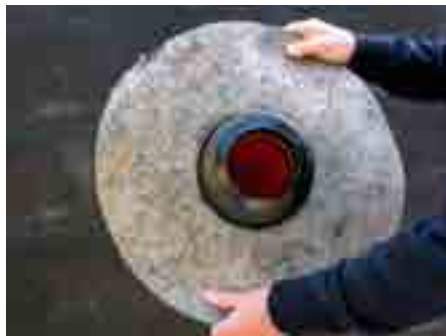
2. Пъха се битумния преход в тръбата
