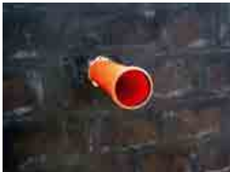
1. Тръба с накрайник муфа, стена с битумен грунд
