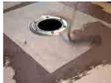
9. Мазаната хидроизолация се полага по цялата площ на мокрото помещение, подложена на пръскаща вода, както и върху мембраната
