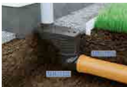
5. Свържете канализационната тръба DN110 - директно DN125 - чрез отрязване!
